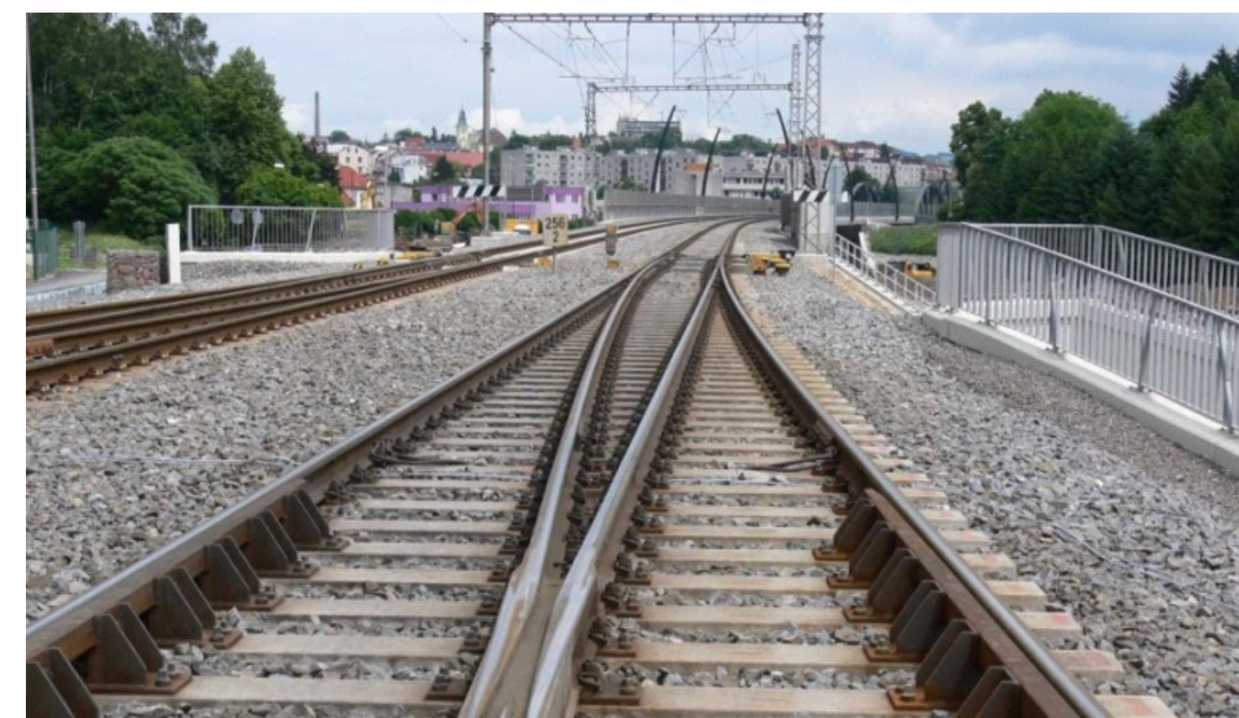
Výhybky s podpražcovými podložkami: vlevo žst. Planá nad Lužnicí, vpravo v žst. Ústí nad Orlicí.
