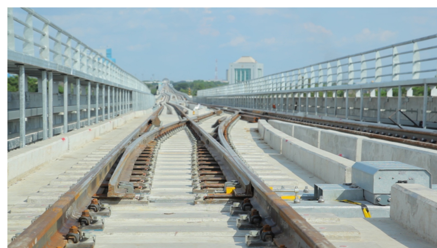
Výhybky se zpružněným upevněním DT - Metro Palembang (Indonésie).
