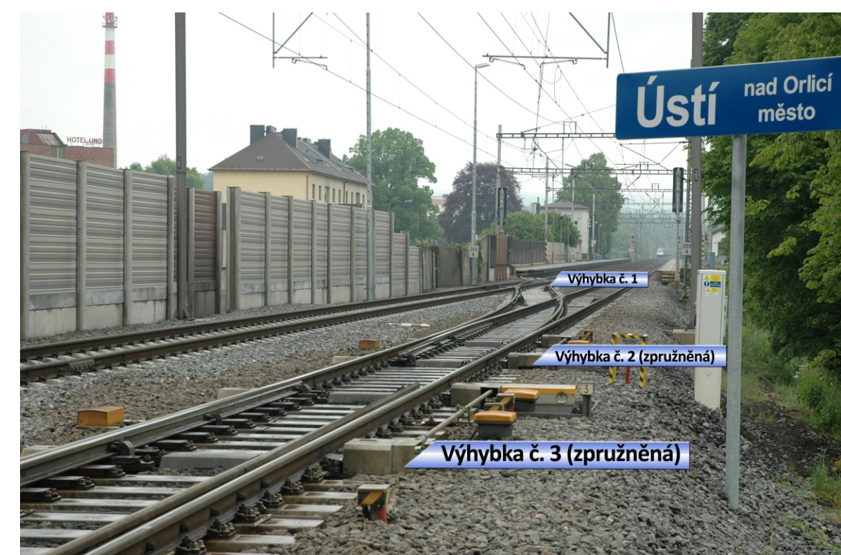
Výhybky č. 2 a 3 se zpružněním v systému upevnění v žst. Ústí nad Orlicí.
